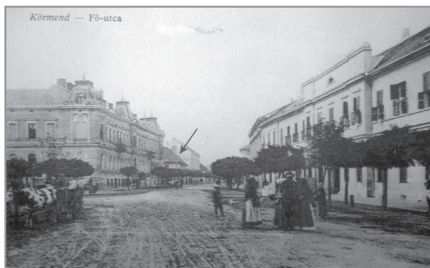
a.) Kőrmend. Faludi János lakóháza lebontása előtt (a nyíllal jelölt épület)
