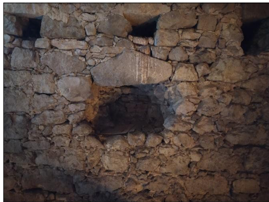
2. ábra. A padlás oromfalán található három kisebb és egy nagyobb áthidaló funkciójú kővel kitámasztott rés
