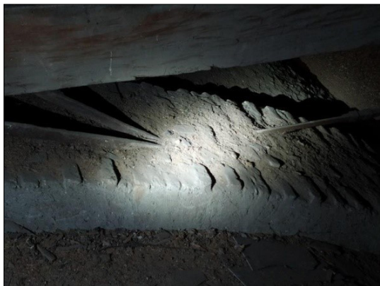
3. ábra. A falak, a boltozat és a tetőszerkezet kapcsolatát biztosító vonóvasak. A szerző fotója.
