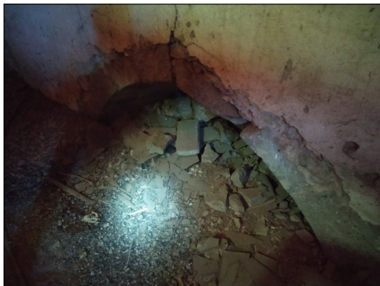
1. ábra. A padláson található befallazott, csúcsíves középkori ablak maradványai
