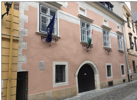
5. ábra. Az Új utca 8. számú épület helyreállított utcai homlokzata (a szerző felvétele)
