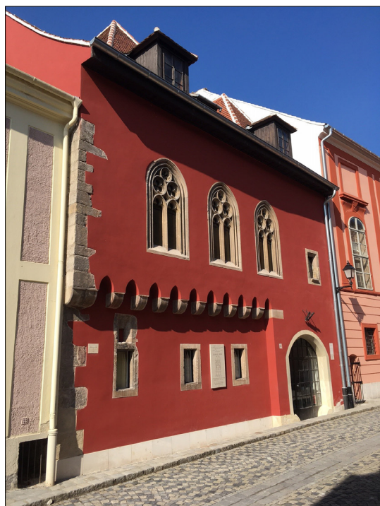
4. ábra. Az Új utca 16. számú épület helyreállított utcai homlokzata (a szerző felvétele)
