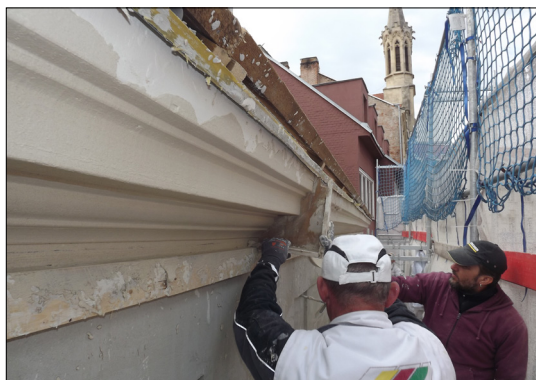
2. ábra. A Hátsókapu 2. épület Szt. György utcai párkányának kialakítása húzókocsival (a szerző felvétele)
