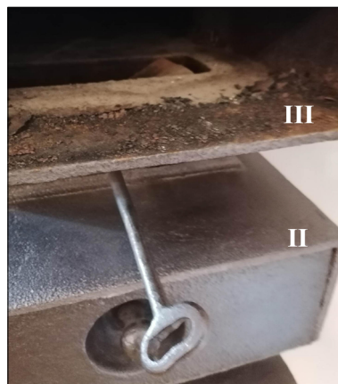
2. ábra. A füstgázvezető, kurtító zárt állapota
