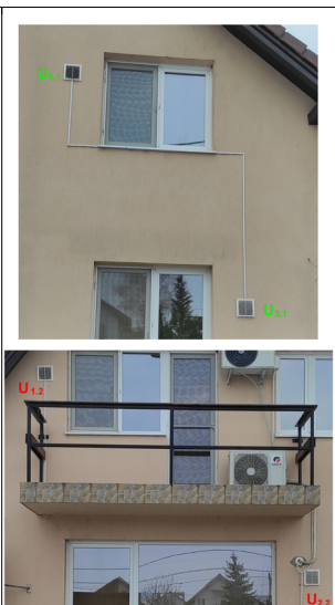
3. ábra. A szellőztetők elhelyezkedése az épület falán
