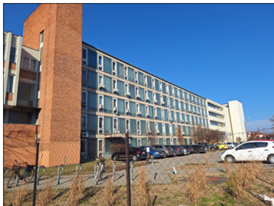
2. ábra. A Műszaki Kar keleti tájolású szárnya
