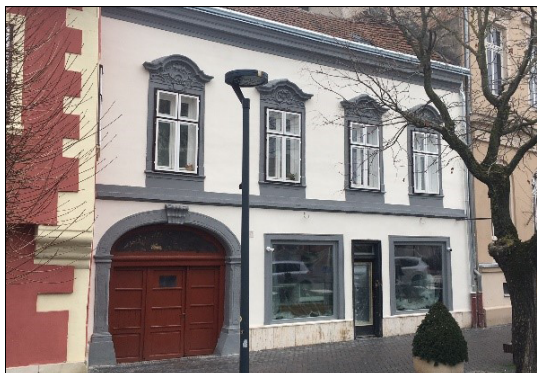
5. ábra. A Várkerület 57. számú épület helyreállított utcai homlokzata (a szerző felvétele)
