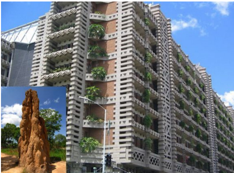
1. ábra. Az Eastgate Centre épület (Harare, Zimbabwe) tervezői a természetek építkezéséből ihletődtek a megfelelő szellőztetés érdekében.
